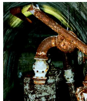
Hinten den Toren gibt es noch viel zu tun. Baustelle Unternehmenskultur.
